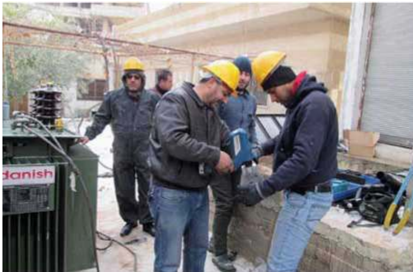
Электрики в пригороде Дамаска. Ремонт электросети будет одной из основных задач восстановления.
